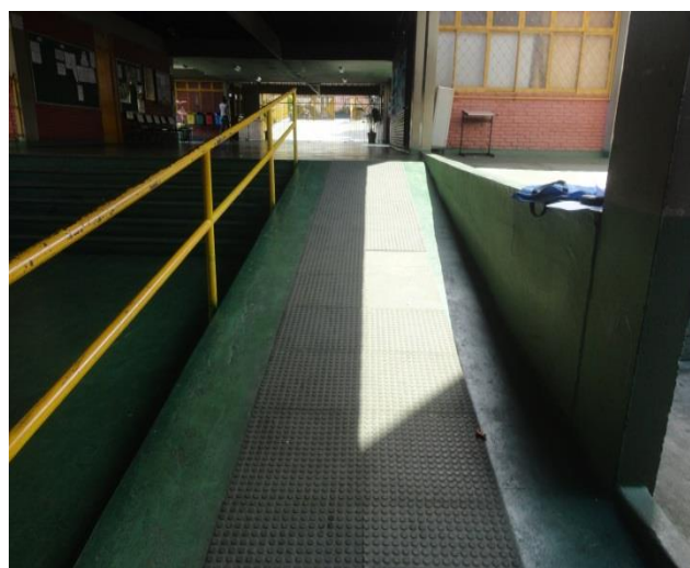
Figura 2: Foto da Rampa da Escola A
