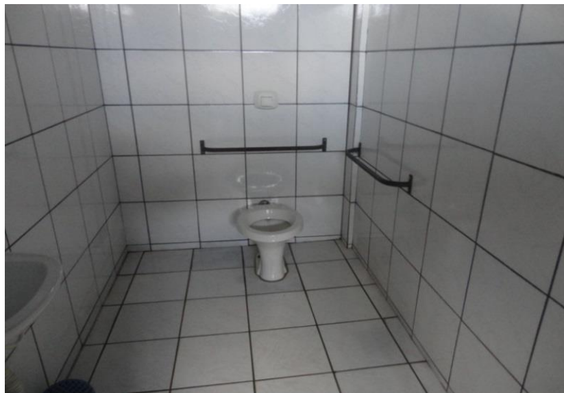
Figura 16: Barras nas medidas especificadas – Escola F
