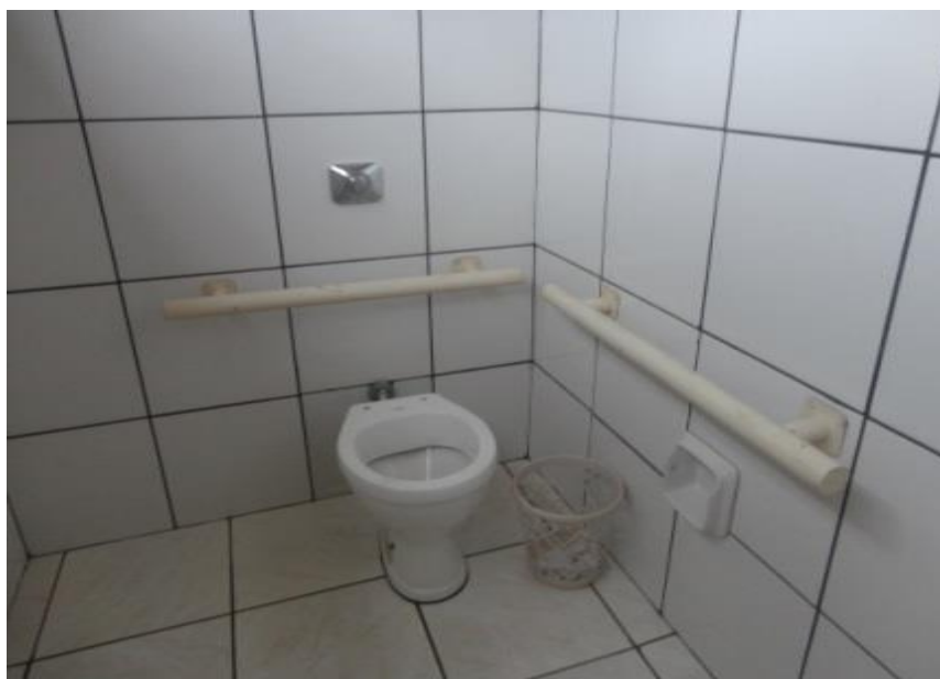
Figura 12: Circulação do banheiro adequada – Escola B
