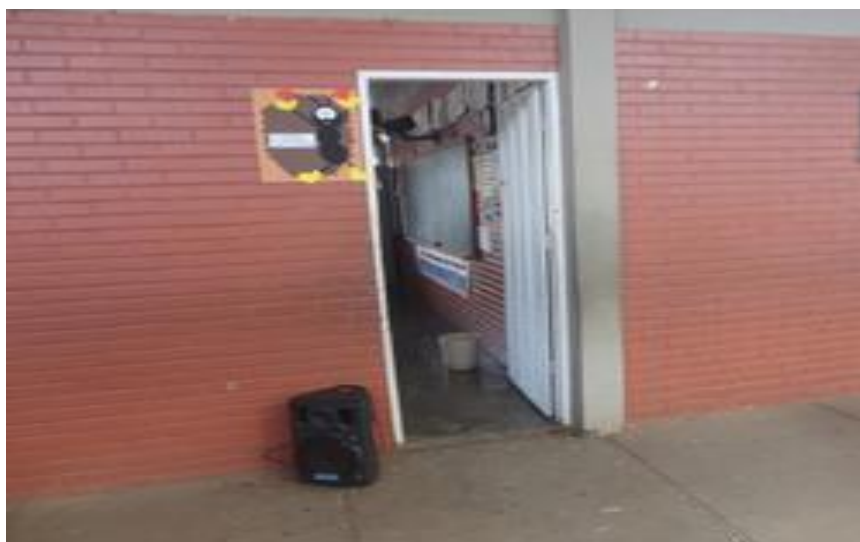
Figura 9: Existência de sala de aula com largura das portas para o acesso de pessoa com deficiência - Escola D
