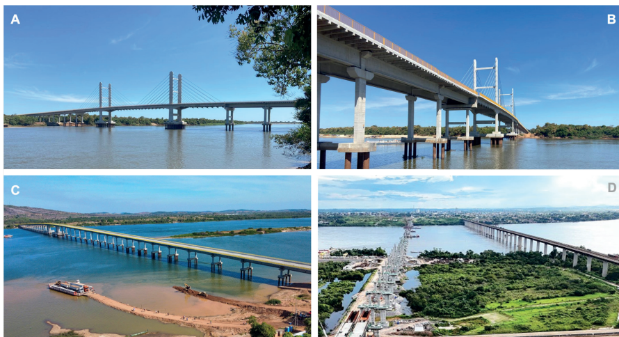
Figuras 2A e 2B - Ponte sobre o Rio Araguaia no povoado de Luiz Alves, na BR-080, em São Miguel do Araguaia (GO); 2C) ponte sobre o Rio Araguaia entre São Geraldo do Araguaia (PA) e Xambioá (TO); 2D) construção de nova ponte sobre o Rio Tocantins ao lado da ponte rodoferroviária de Marabá (PA). Fontes: 2A e 2B - Fotografias feitas pelo autor, durante trabalho de campo, em 9 de julho de 2024; 2C - Diário do Pará (2024); 2D - Correio de Carajás (2025).
