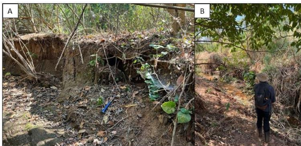
Figura 21: A e B) Erosão em voçorocas no curso d'água no mesmo ponto. (Coordenada: 692124 8165262 22S - Ponto TFAAI-D38).
