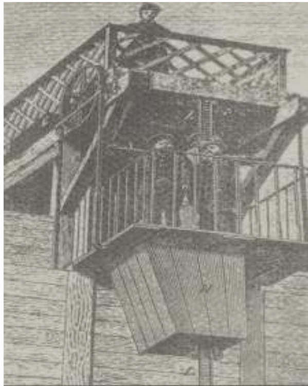
Figura 2.4 - Elevador com motor elétrico.
