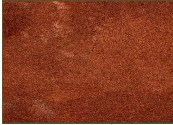
Detalhe fachada em aço patinável
