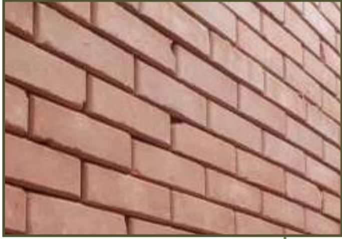
Detalhe fachada bloco aparente
