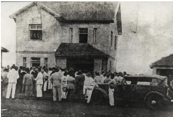
Construção de casas-tipo na cidade de Goiânia Foto divulgação [Gerência de Documentação, Cartografia e Topografia / Seplanh]
