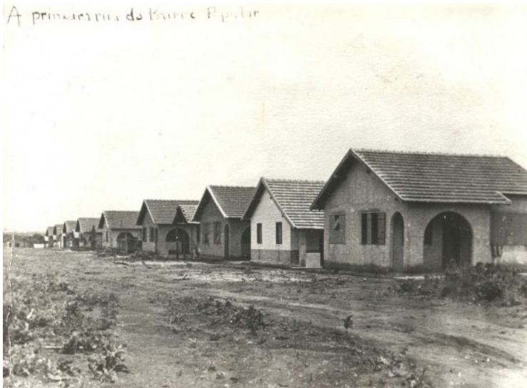
Construção de casas-tipo na cidade de Goiânia Foto divulgação [Gerência de Documentação, Cartografia e Topografia / Seplanh]
