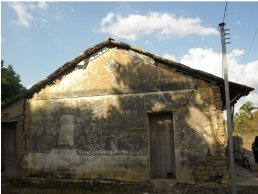
Figura 2 — Foto da lateral casa grande no ano 2011.
