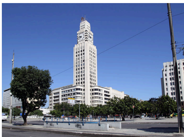
Figura 8 - Estação Central do Brasil, (Edifício Dom Pedro II)
