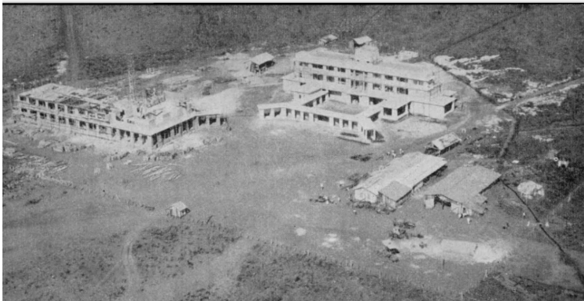
Figura 35 - Momento em que Atílio teria deixado as obras da cidade de Goiânia em 1935 (Rezende, 2021), são visíveis os primeiros edifícios públicos de Goiânia no centro cívico, mostrando o palácio do governo e o prédio da Secretaria geral ainda em construção.
