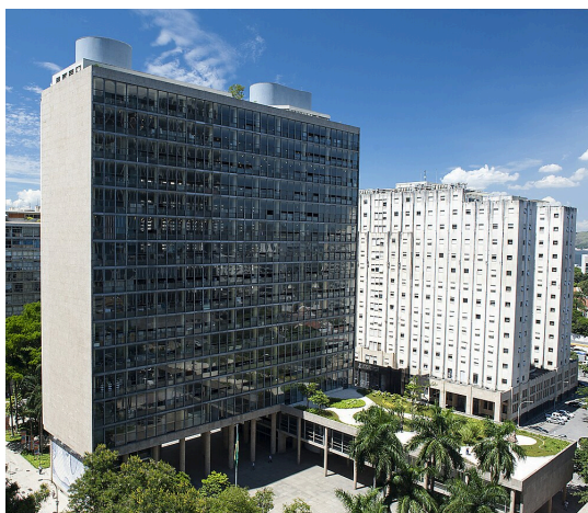
Figura 5 - Ministério da Educação e Saúde Pública, fachada sul do Palácio Capanema
