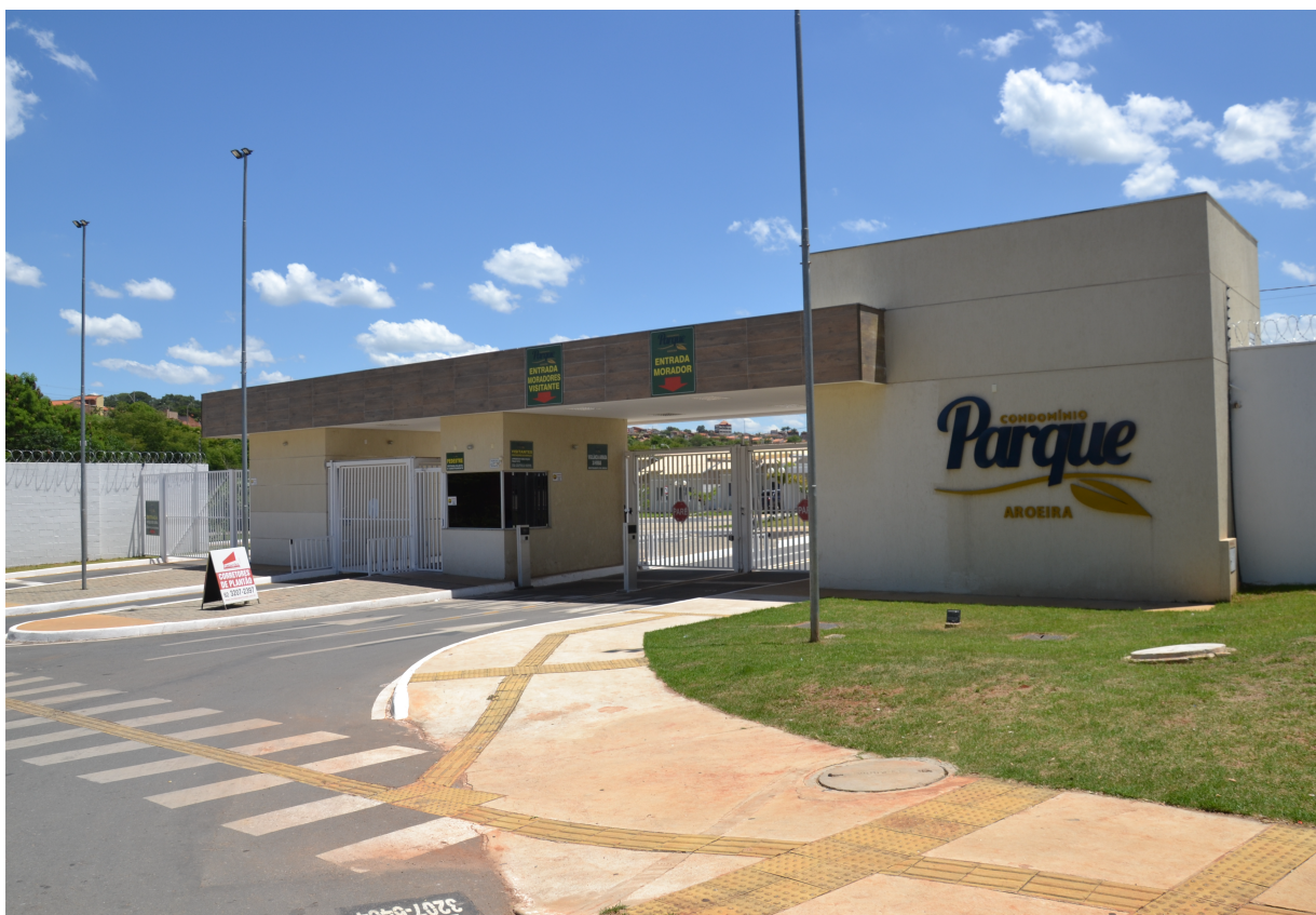
Figura 10. Portaria de uns dos condomínios no Jardim Guanabara II
