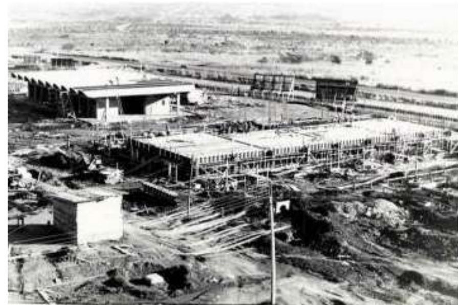
Figura 33: CEASA-GO: Vista geral dos pavilhões em construção
