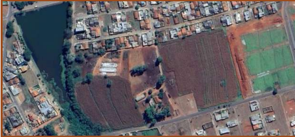
Figura 45: Entorno da área de intervenção
