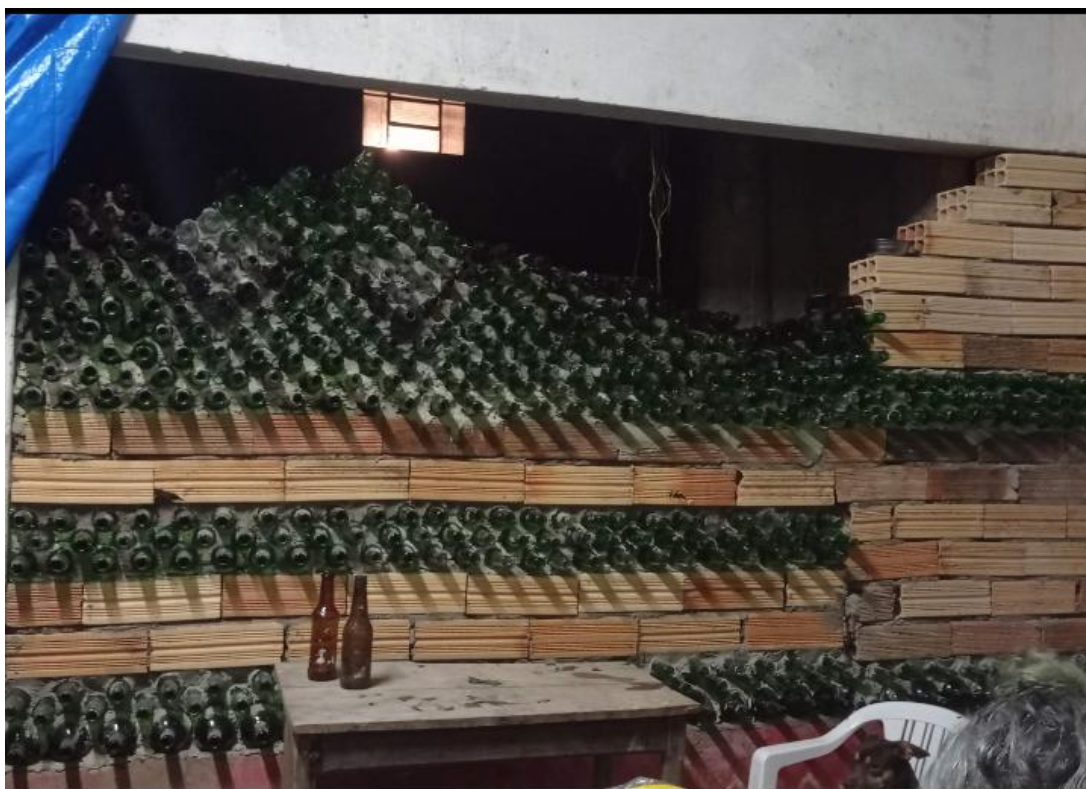
Figura 3 — Construção de parede de garrafas.
