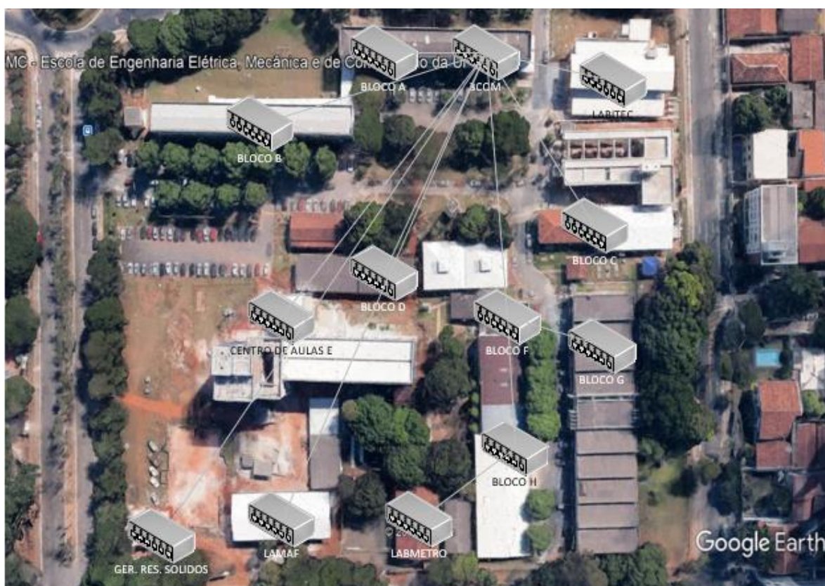
Figura 25 - Rede interna da Escola de Engenharia da UFG
