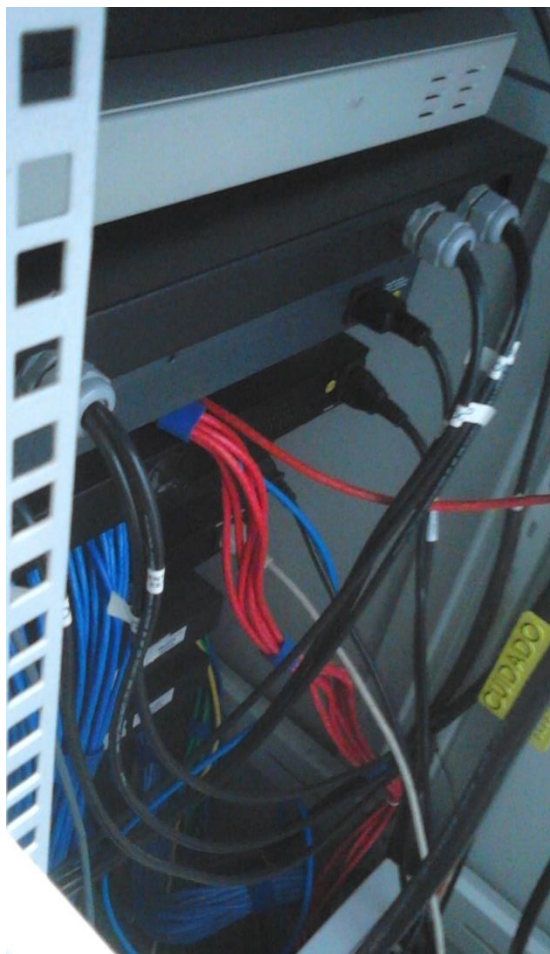
Figura 42 - Cabos organizados aumentaram o espaço livre e facilitaram a identificação visual
