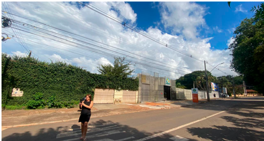
Figura 44: Vista 3, fachada Rua 225. Fonte: da autora, 2026.
