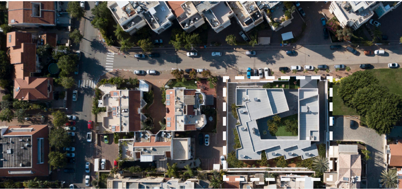
Figura 30: Localização do Abrigo para Vítimas de Violência Doméstica . O abrigo está destacado em contorno branco. Foto: Amit Geron, s.d. Fonte: Adaptado de Archdaily, 2018. Disponível em: < https://www.archdaily.com.br/br/895789/abrigo-para-vitimas-de-violencia-domestica-amos-goldreich-architecture-plus-jacobs-yaniv-architects >. Acesso em: 16 set. 2025.
