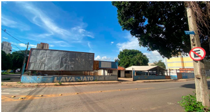
Figura 42: Vista 1, fachada Rua 236. Fonte: da autora, 2026.
