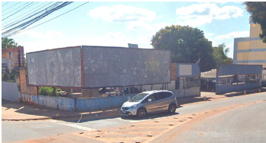
Figura 43: Vista 2, esquina com as ruas 236 e 225. Fonte: Google Earth, 2025.
