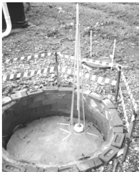
Figura 11 - Poço de infiltração acabado (detalhe da bóia de leitura de nível)
