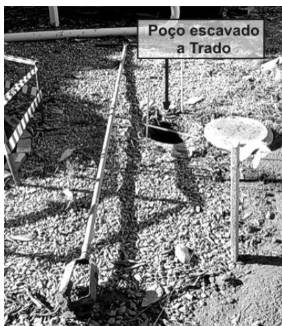
Figura 14 - Detalhe do poço escavado a trado afastado 1,0 m do poço de infiltração
