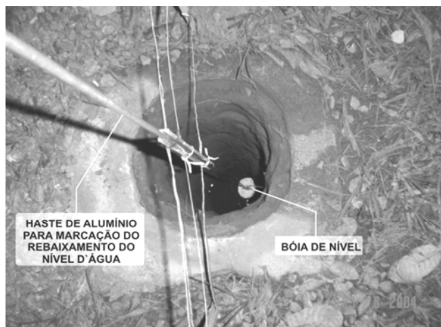
Figura 15 - Ensaio de permeabilidade - bóia indicando o nível de rebaixamento de água no poço escavado a trado
