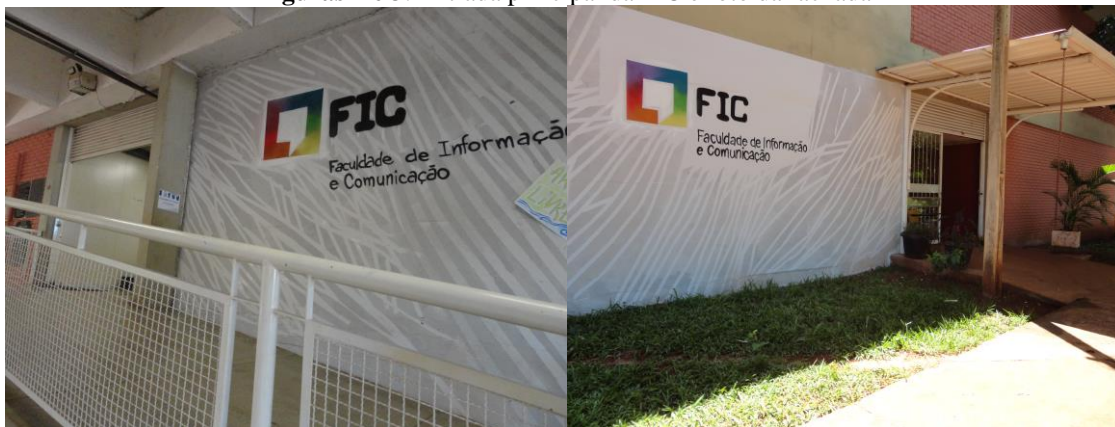
Figuras 2 e 3: Entrada principal da FIC e foto da fachada
