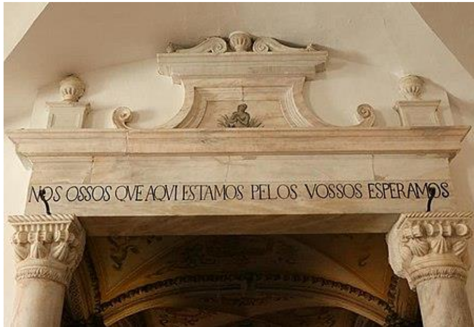
Figura 15 - Entrada da Capela dos Ossos
