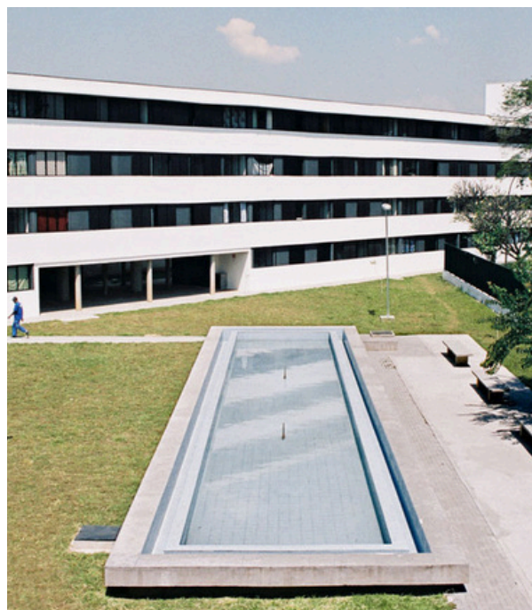
Figura 25: Vista pátio interno da Vila dos Idosos. Fonte: Vigliecca & Associados, [s.d.].
