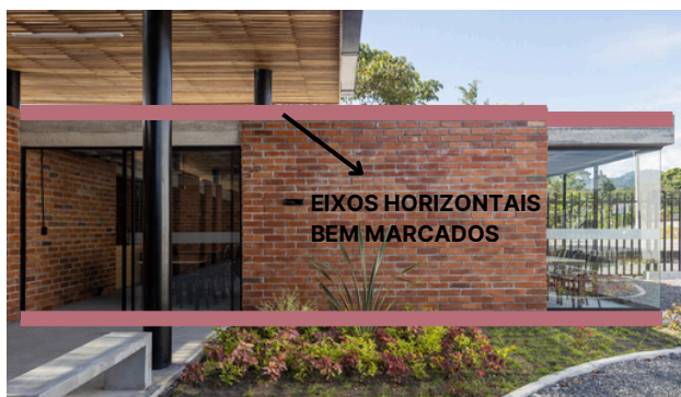
Figura 37: Salas do Centro Dia para Idosos. Fonte: ArchDaily, 2023 com intervenção da autora.
