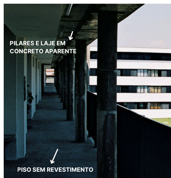
Figura 28: Imagem do corredor da Vila dos Idosos. Fonte: Vigliecca & Associados, [s.d.] com intervenção da autora.
