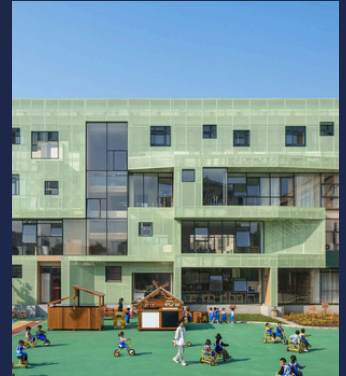
Reforma do Centro Comunitário Intergeracional Hebi, China
