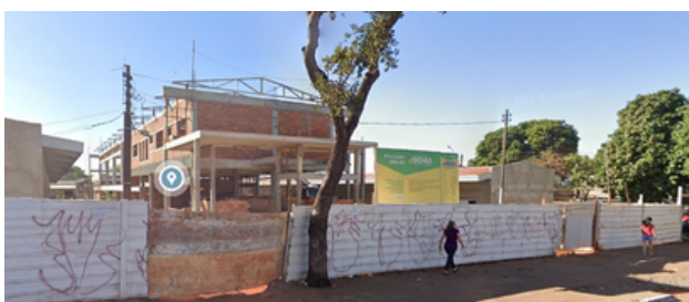
Figura 15: Imagem da Casa do Idoso em obras. Fonte: Google Street View, 2024.
