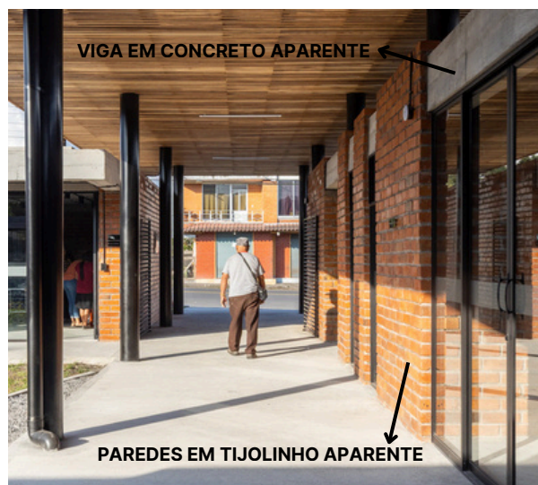
Figura 34: Circulação do Centro Dia para Idosos. Fonte: ArchDaily, 2023 com intervenção da autora.
