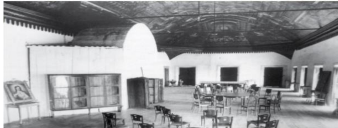
Figura 3 - Salão de leitura da Biblioteca
