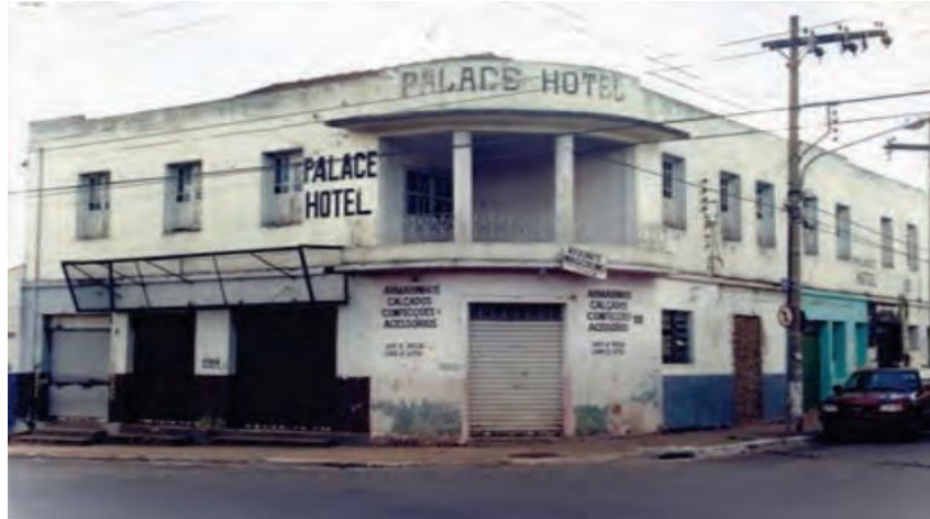
Figura 18 - Fachada frontal do Palace Hotel abandonada
