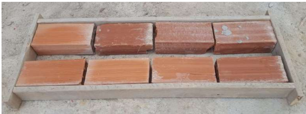
Foto: organização dos tijolos do painel cerâmico - Fonte: arquivo pessoal
