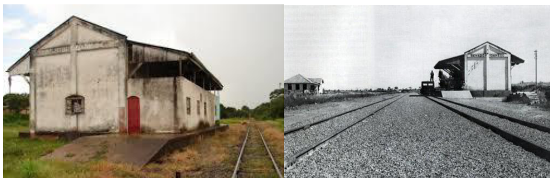
Figura 3: Fotos da Estação Ferroviária de Senador Canedo
