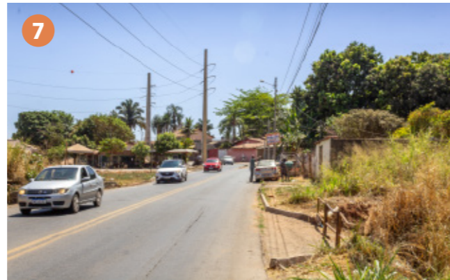
Figura 68: Via local - Av. José Leandro da Cruz Fonte: Heitor Rocha, 2024
