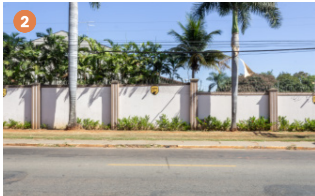
Figura 103: Fachada inativa de condomínio horizontal Fonte: Heitor Rocha, 2024
