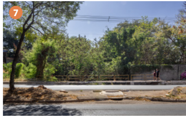
Figura 96: Travessia sobre Córrego Serrinha Fonte: Heitor Rocha, 2024
