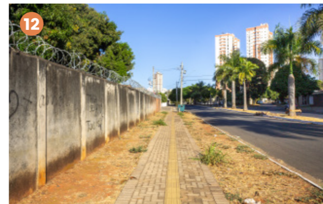
Figura 86: Calçada com piso tátil Fonte: Heitor Rocha, 2024
