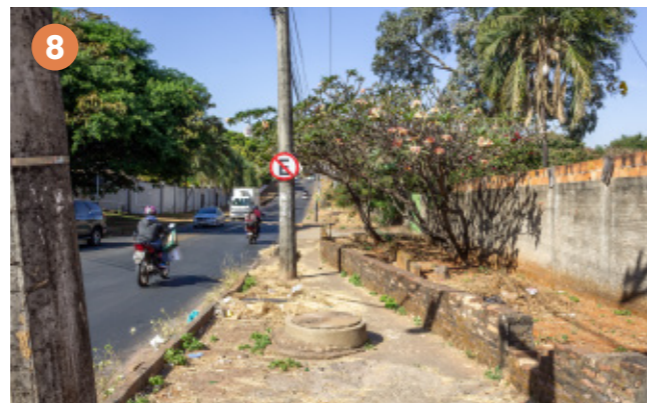
Figura 82: Infraestrutura de bueiro em calçada Fonte: Heitor Rocha, 2024
