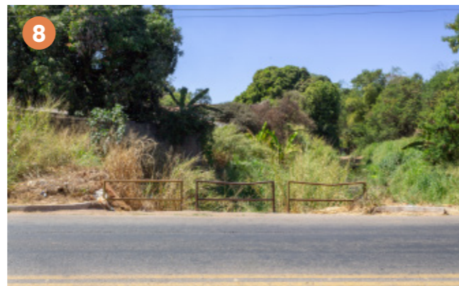
Figura 97: Travessia sobre Córrego Serrinha Fonte: Heitor Rocha, 2024
