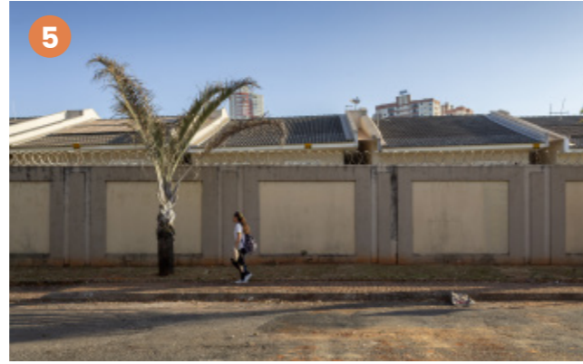
Figura 106: Fachada inativa de condomínio horizontal Fonte: Heitor Rocha, 2024
