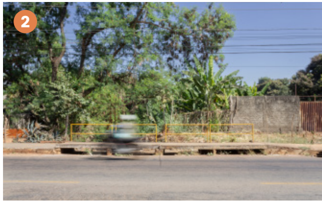
Figura 91: Travessia sobre Córrego Serrinha Fonte: Heitor Rocha, 2024
