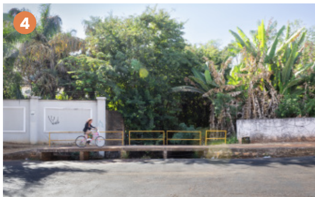
Figura 93: Travessia sobre Córrego Serrinha Fonte: Heitor Rocha, 2024
