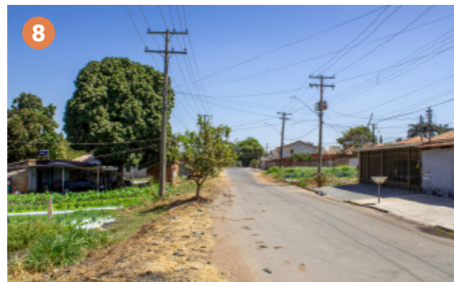
Figura 69: Via coletora - Av. C107 Fonte: Heitor Rocha, 2024
