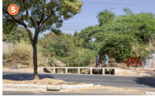
Figura 94: Travessia sobre Córrego Serrinha Fonte: Heitor Rocha, 2024
