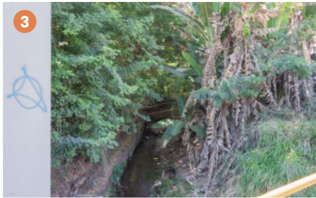
Figura 121: Visada ao Córrego Serrinha Fonte: Heitor Rocha, 2024
