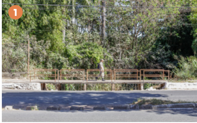
Figura 90: Travessia sobre Córrego Serrinha Fonte: Heitor Rocha, 2024
