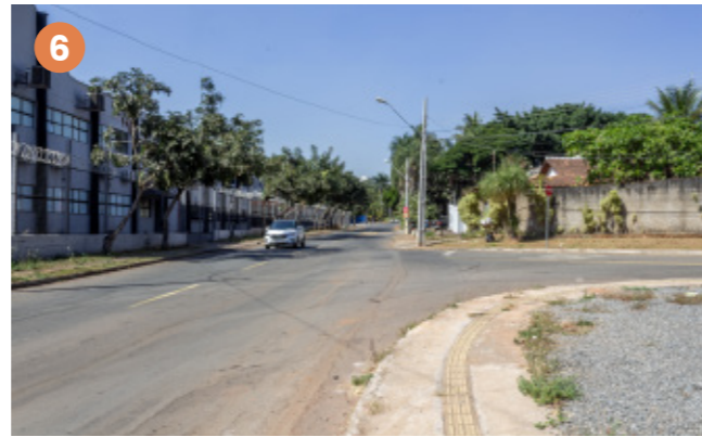
Figura 80: Calçada com piso tátil Fonte: Heitor Rocha, 2024
