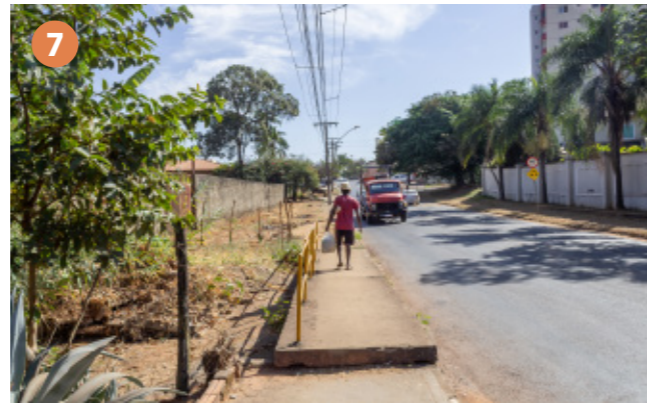
Figura 81: Desnívelamento em travessia de pedestre Fonte: Heitor Rocha, 2024
