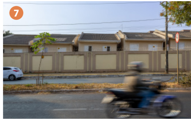
Figura 108: Fachada inativa de condomínio horizontal Fonte: Heitor Rocha, 2024
