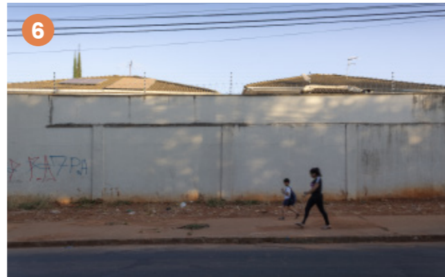
Figura 107: Fachada inativa de condomínio horizontal Fonte: Heitor Rocha, 2024
