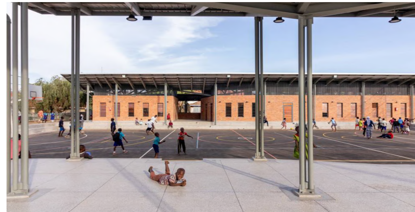
Figura 76: Centro Comunitário Kamwokya. Fonte: ArchDaily, 2024.
