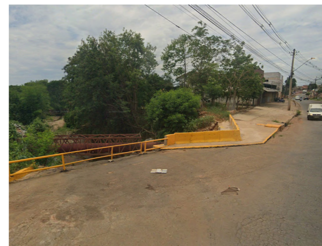
Figura 20: Ponte sobre córrego no encontro entre Av. Goiás e Av. Genésio de Lima Brito. Fonte: Google Street View, 2024.
