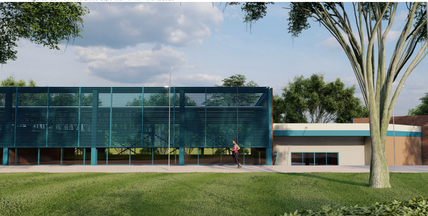
Figuras 136. Fachada Bloco Esportes. Fonte: Autora, 2025
