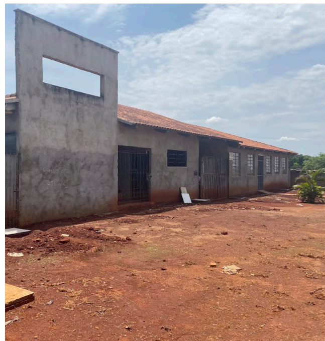
Figura 35: Centro de apoio ao idoso em fase de construção. Fonte: Autora, 2024.
