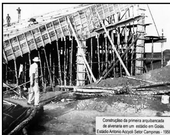
Figura 12: Construção da arquibancada.
