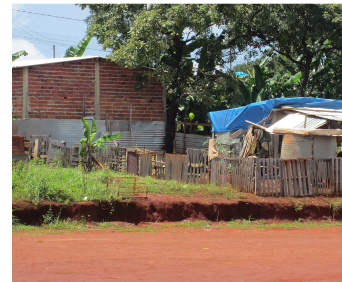
Fig.76- Desnível e fechamento com tábuas de madeira/ palets. Fonte: Acervo da autora.
