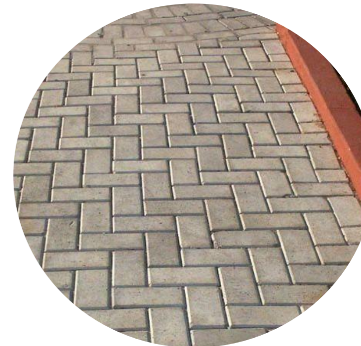
PISO INTERTRAVADO DE CONCRETO
