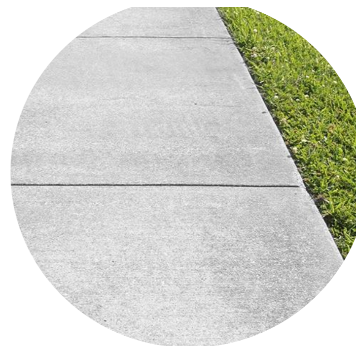
PISO DE PLANCAS DE CONCRETO
