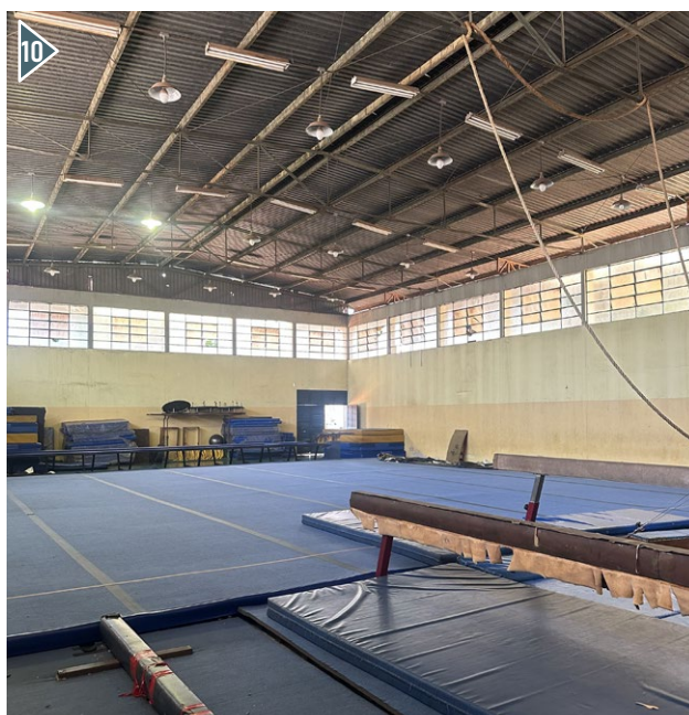
Figura 44: Vista interna do ginásio de ginástica artística. Fonte: Acervo pessoal, 2025.
