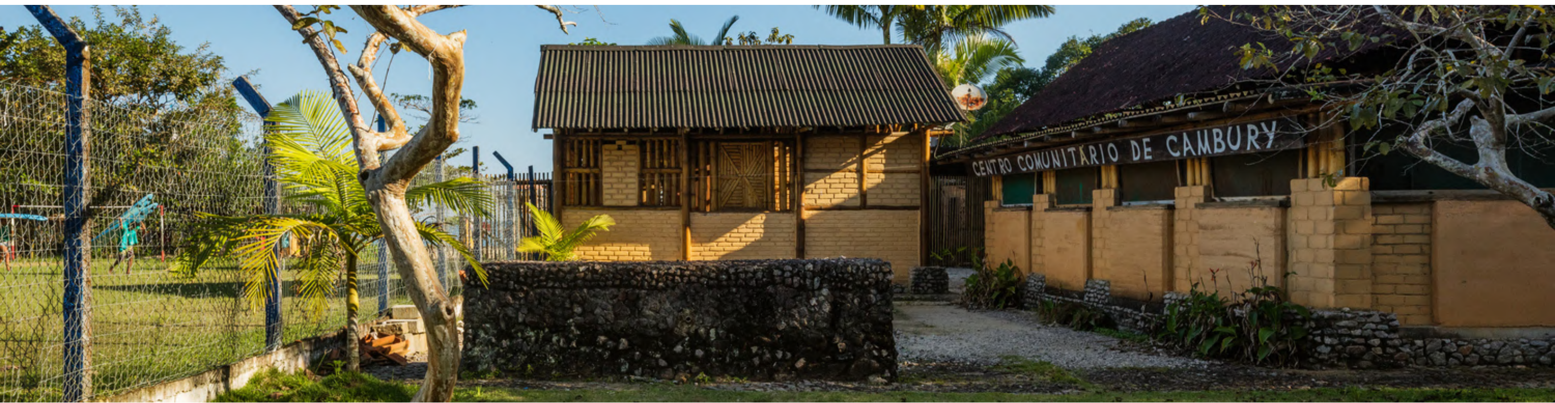
Figura 26: Centro Comunitário Camburi - Planta baixa. Fonte: ArchDaily Brasil - com adaptações da autora. Figura 27: Centro Comunitário Camburi - Fachada. Fonte: Nelson Kon.
