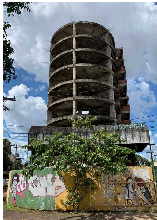
FIGURA 22 - Edifício desocupado na Avenida Araguaia, Setor Central, Goiânia. (Número 2 no Mapa 3). Fonte: Autora
