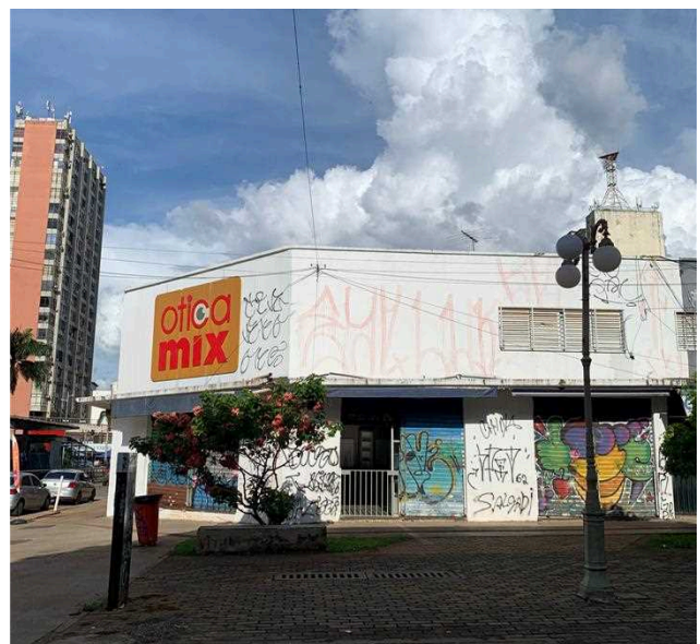
FIGURA 12 - Comércio desocupado na Rua do Lazer, Setor Central, Goiânia. Fonte: Autora
