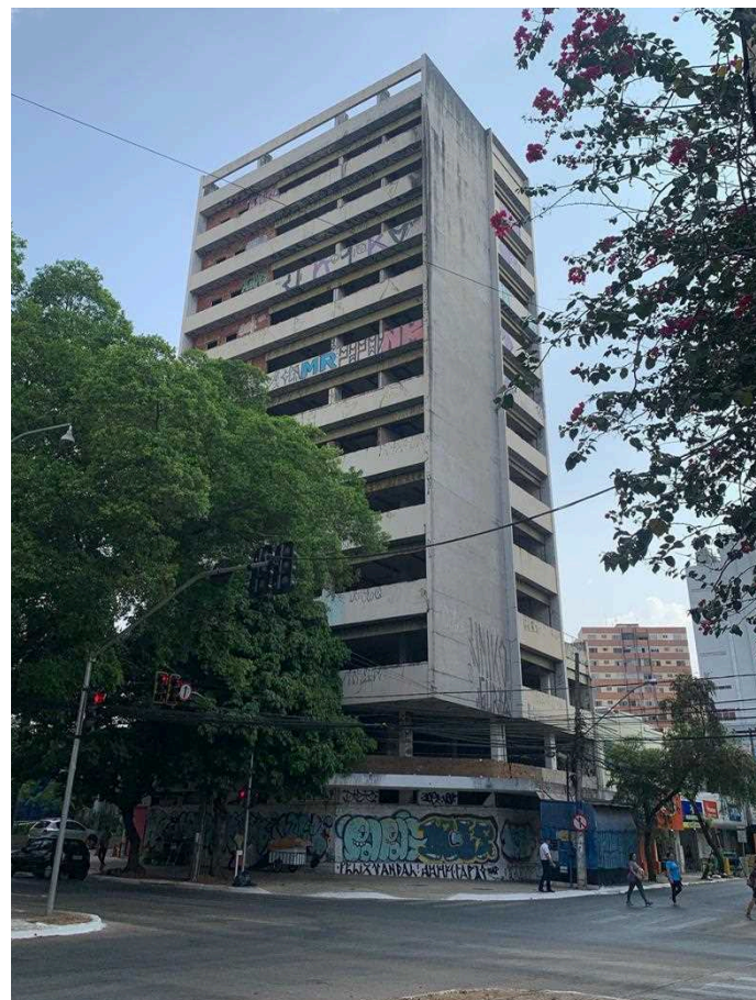
FIGURA 21 - Edifício desocupado na Rua 2 com a Avenida Goiás, Setor Central, Goiânia. (Número 1 no Mapa 3). Fonte: Autora
