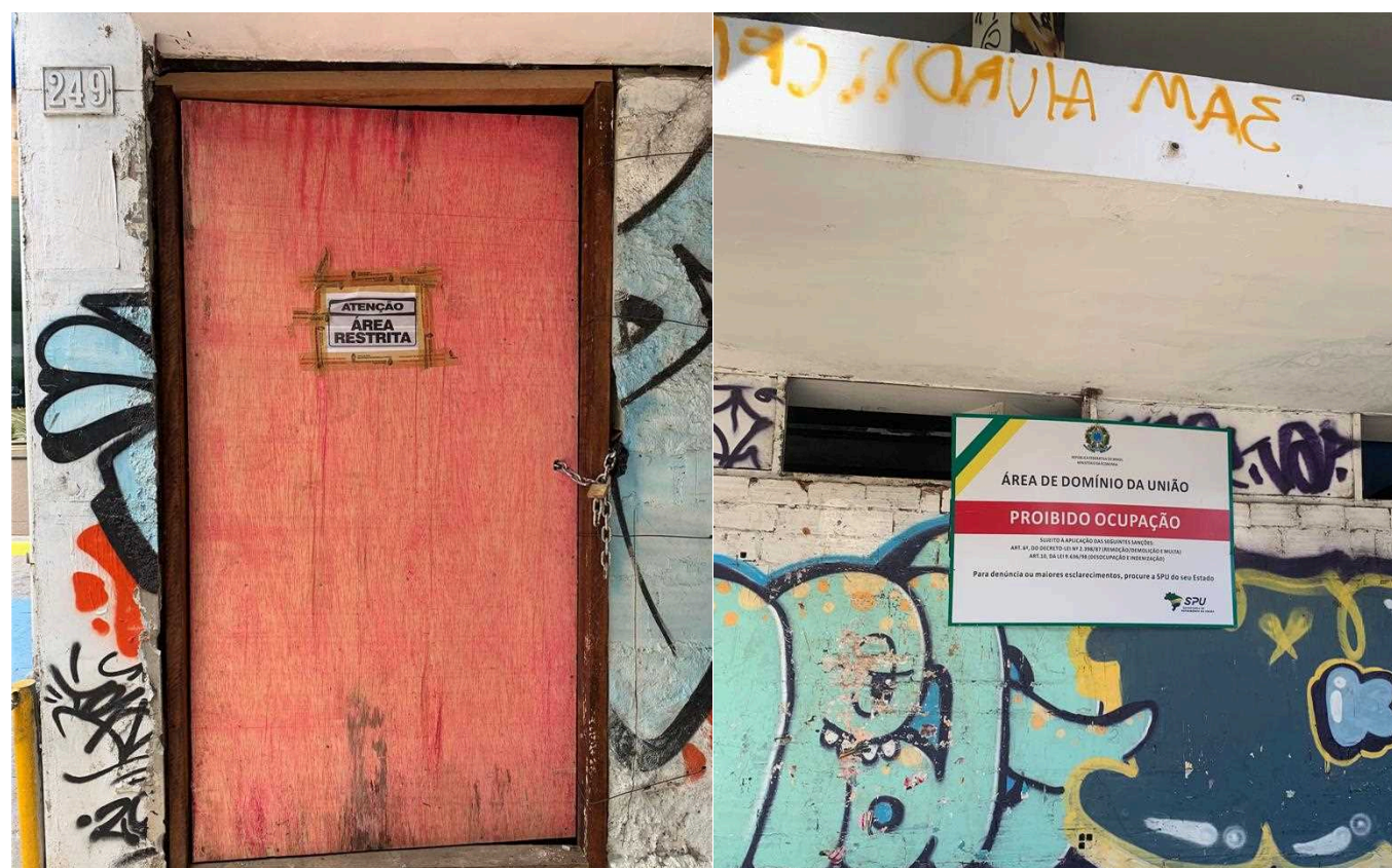
FIGURA 37, E 38 - Placas de aviso na entrada do edifício - Fonte: Autoria
