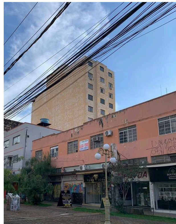
FIGURA 14 - Comércio desocupado na Rua do Lazer, Setor Central, Goiânia. Fonte: Autora
