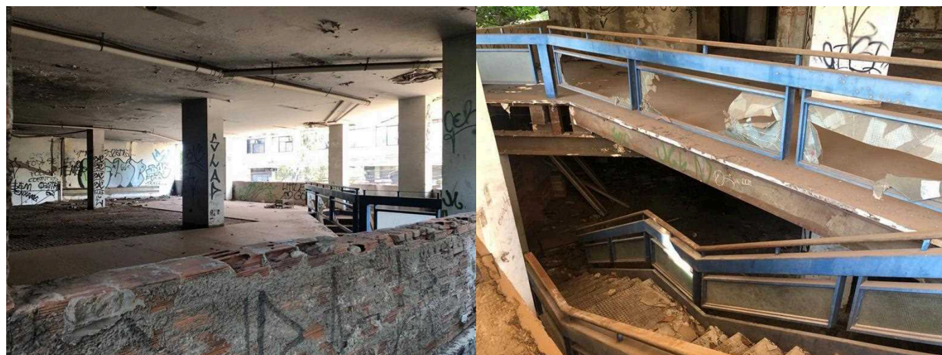
FIGURA 35 E 36 - Fotos internas do edifício - Fonte: Autoria desconhecida
