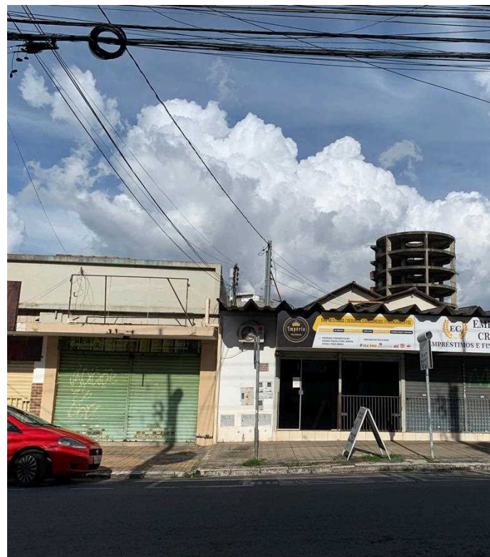
FIGURA 13 - Comércio desocupado na Rua 7, Setor Central, Goiânia. Fonte: Autora
