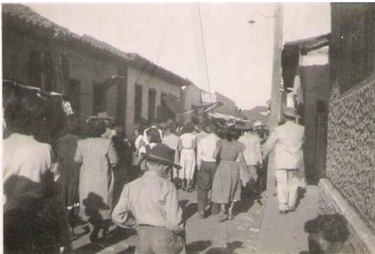
Figura 9. Beco dos Aflitos, 1939
