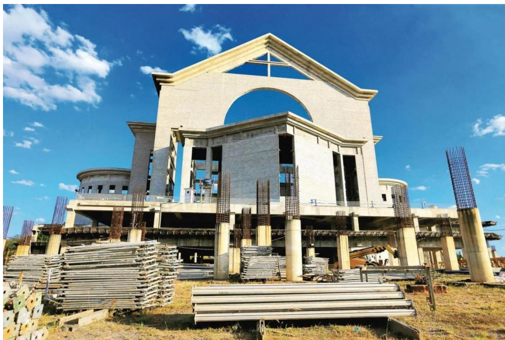
Figura 7. Canteiro de obra do novo Santuário
