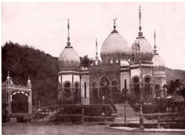
Figura 3 — Pavilhão Mourisco antes da demolição.
