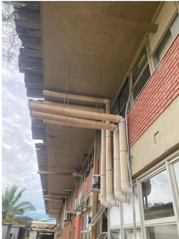
Figura 7 – Altura do duto sem filtragem na mesma direção das janelas do piso 1 do prédio do IQ2.
