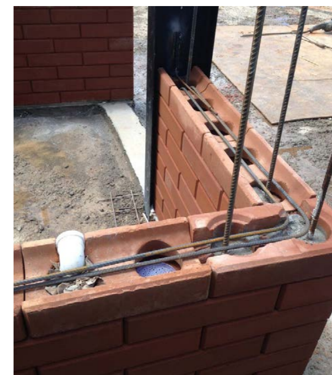
Fig. 66 | Grauteamento de pilares com ferragens e interligação com a cinta de amarração Fonte: Pinterest
