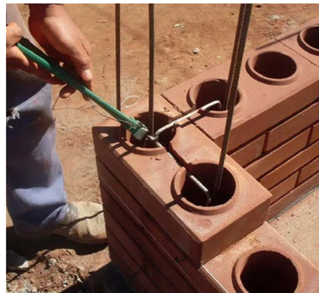
Fig. 70 | Amarração nas quinas de parede com tijolo ecológico Fonte: Google Imagens
