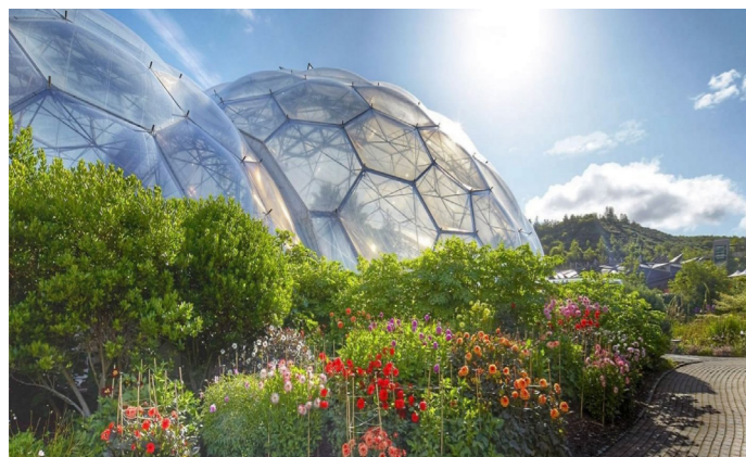
Figura 25: Domo Geodésico, estufa em The Eden Project Fonte: Site oficial Eden Project
