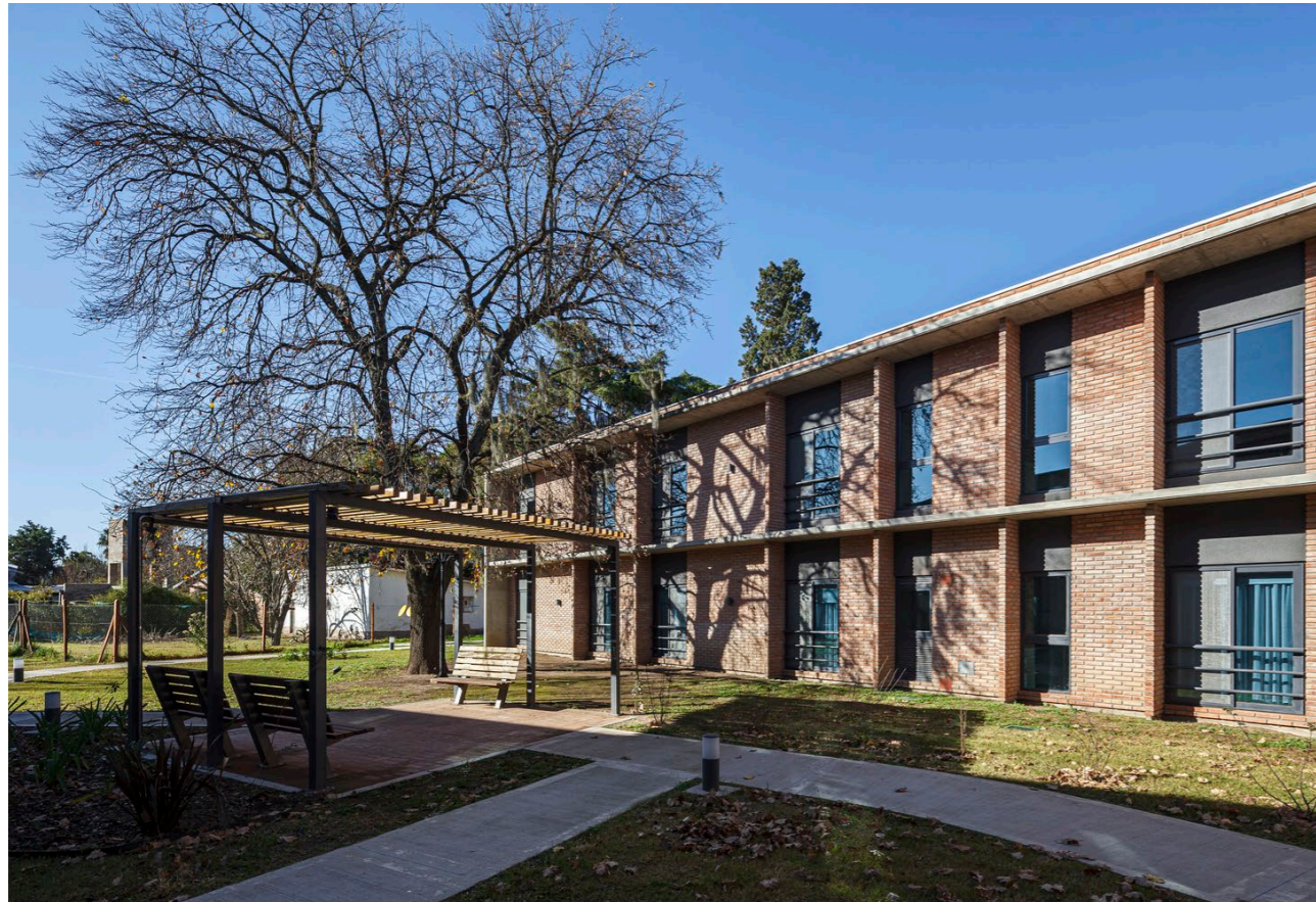
Imagem 20: Vista do externa Centro Sentidos para Idosos. Fonte: ArchDaily, 2022.
