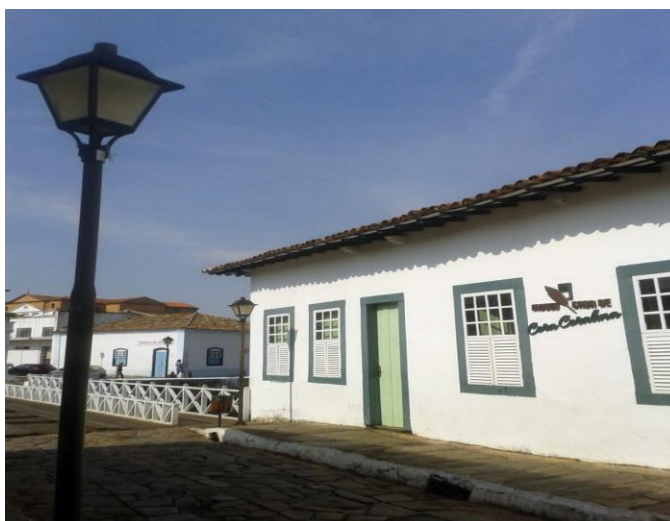
Figura 10 - Fachada do Museu Casa de Cora Coralina
