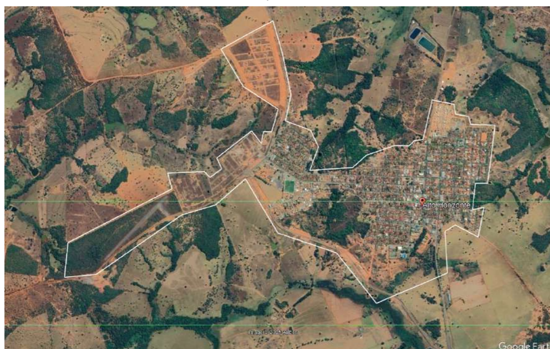
IMAGEM 1 - Vista Superior de Alto Horizonte
