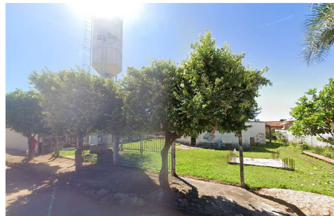
IMAGEM 60 - Estação de Tratamento de Água
