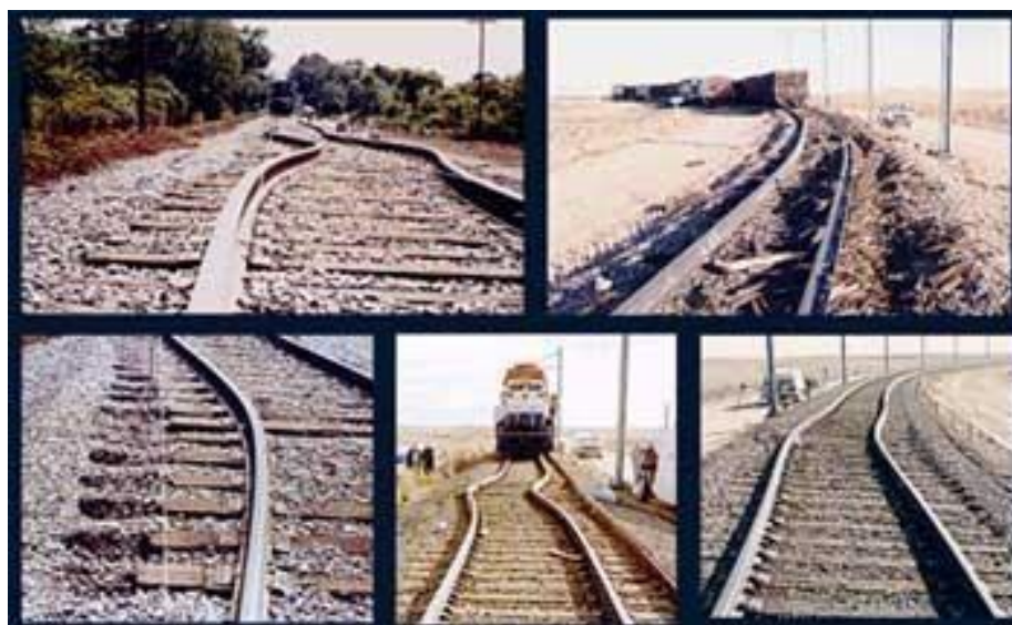
Figura 19 - Efeitos da dilatação em trilhos de trem.
