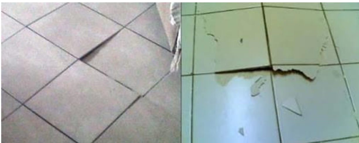
Figura 20 - Efeitos da dilatação térmica em cerâmicas.
