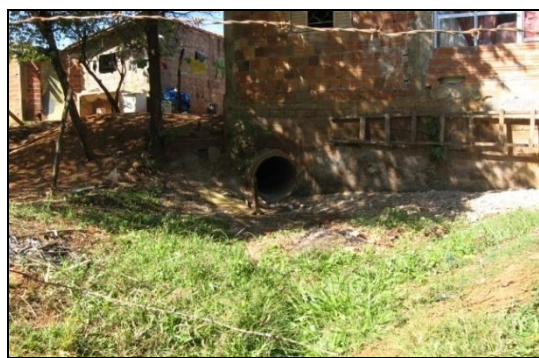
5 – Foto de galeria pluvial com lançamento da água a meia vertente.
