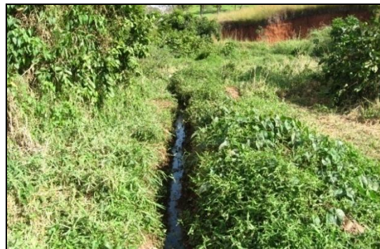
2 – Foto de lançamento irregular de esgoto no Córrego Pedreira.
