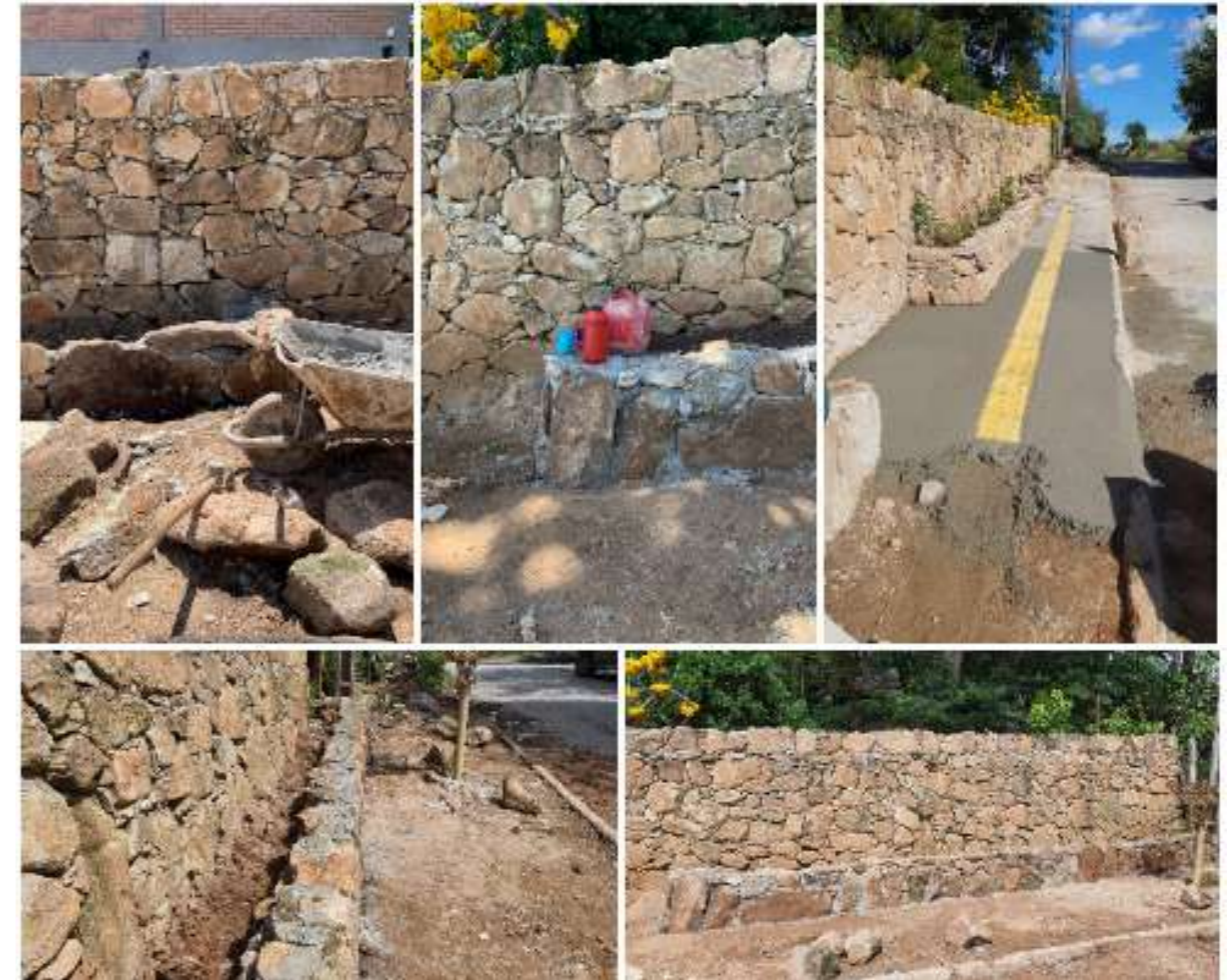
Figura 94: Andamento da execução do projeto da fachada, foram construídos os canteiros, piso, instalação do piso tátil e plantio de algumas espécies.
