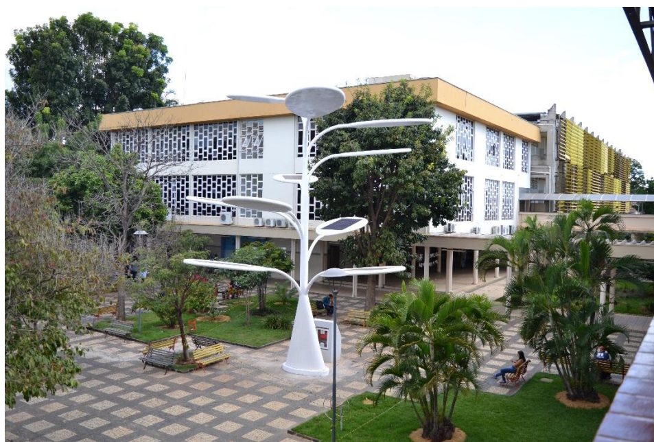
Figura 3.4.1- Árvore solar instalada no campus do IFG
