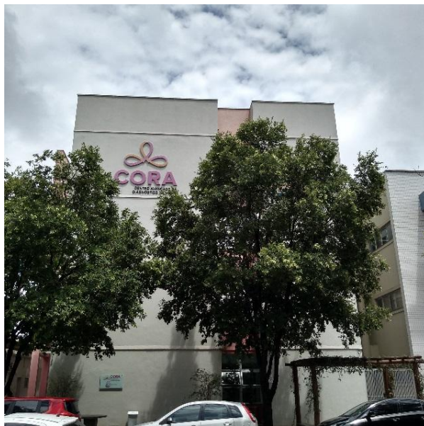
Figura 3.2 – Vista do prédio Centro Avançado em Diagnósticos da Mama.
