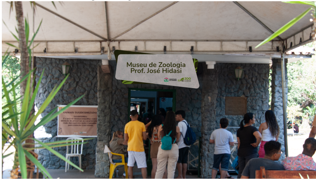
Figura 46: Aplicação da fachada do Museu.
