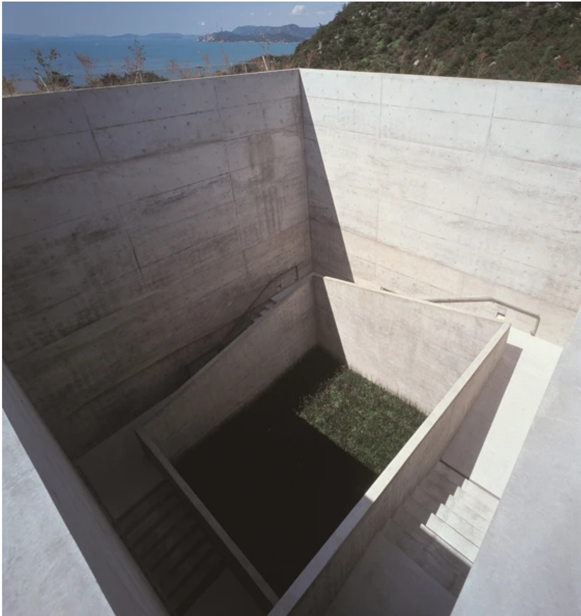
Figura 48- Escada com iluminação natural do Museu de Arte de Chichu
