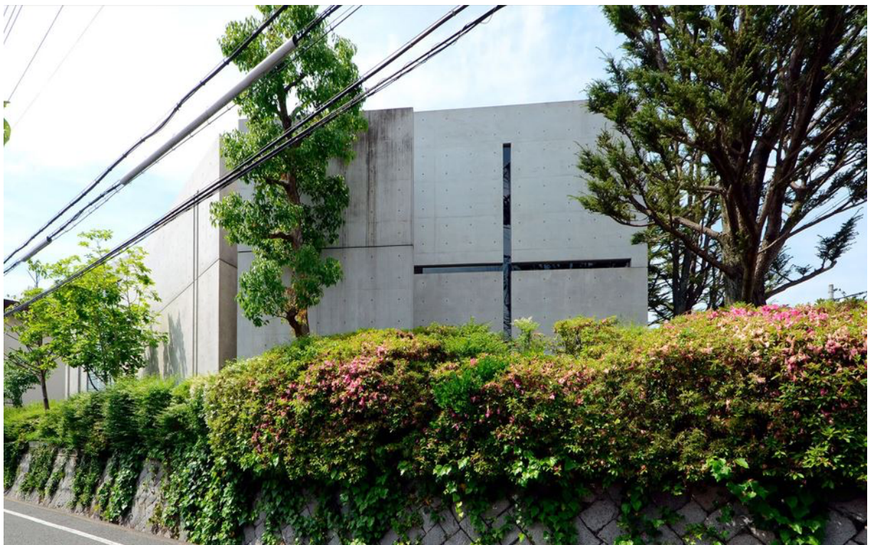
Figura 32 - Fachada lateral com rasgo em cruz da Igreja da Luz
