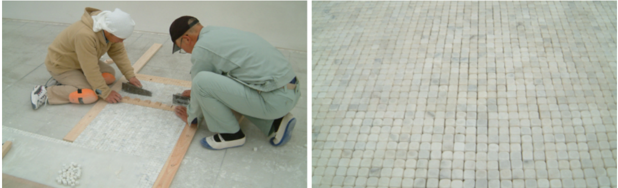
Figura 53- Piso de mármore sendo instalado artesanalmente, Museu de Arte de Chichu
