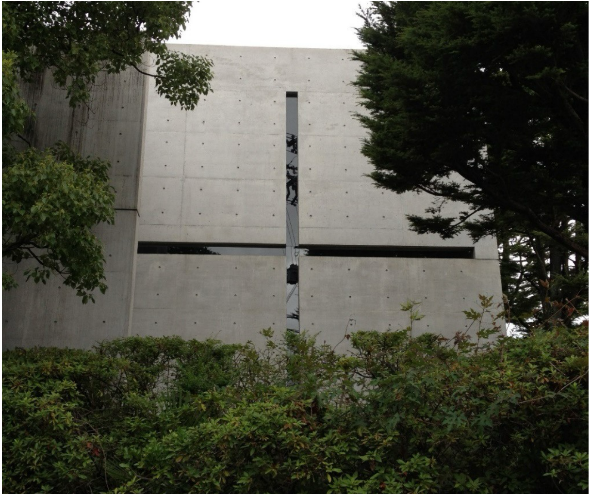
Figura 37- Árvores na parte externa da Igreja da Luz
