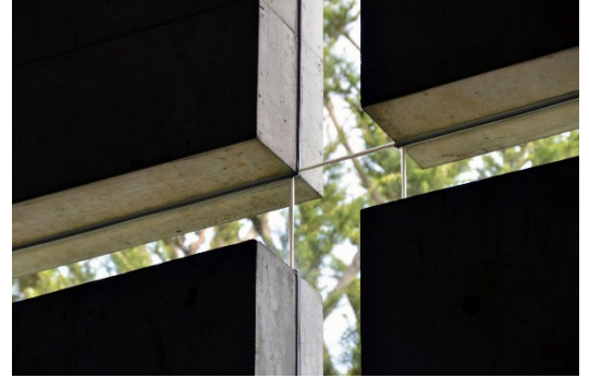
Figura 35 - Detalhe do rasgo em cruz da Igreja da Luz
