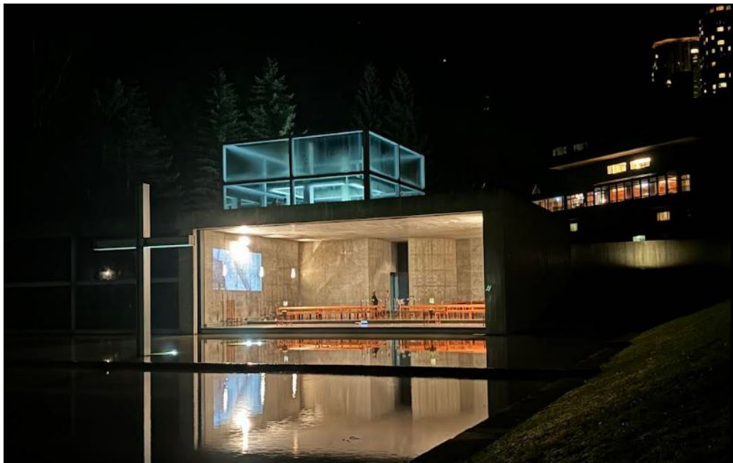
Figura 29 - Vista noturna da fachada principal da Igreja da Água
