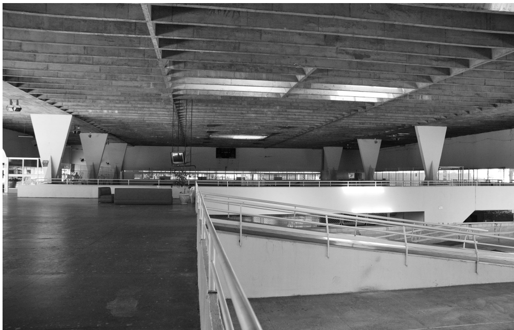
Figura 14. Sistema constructivo-espacial: losa nervada, pilares articulados, rampas, pasarelas y desniveles, 2012. Vista desde la pasarela que conecta la porción oeste (canchas deportivas y bosque) con la Plaza de las Piscinas. Fotografía: José Artur D'Aló Frota. Fuente: Colección del autor.
