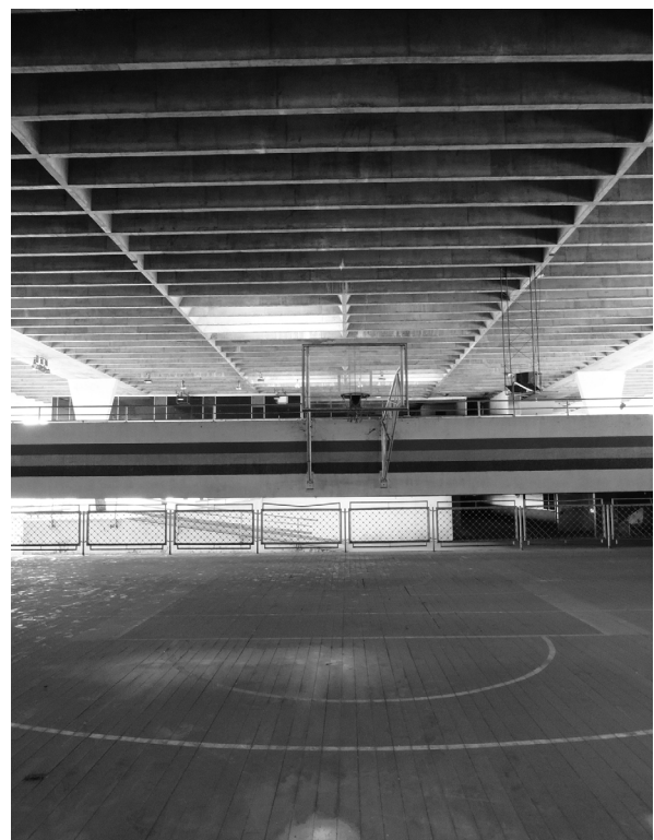
Figura 19. Gimnasio de deportes: buen estado de conservación de la estructura espacial y constructiva, 2019. Fotógrafa: Jéssica Pinheiro de Vasconcelos. Fuente: Colección de la autora.
