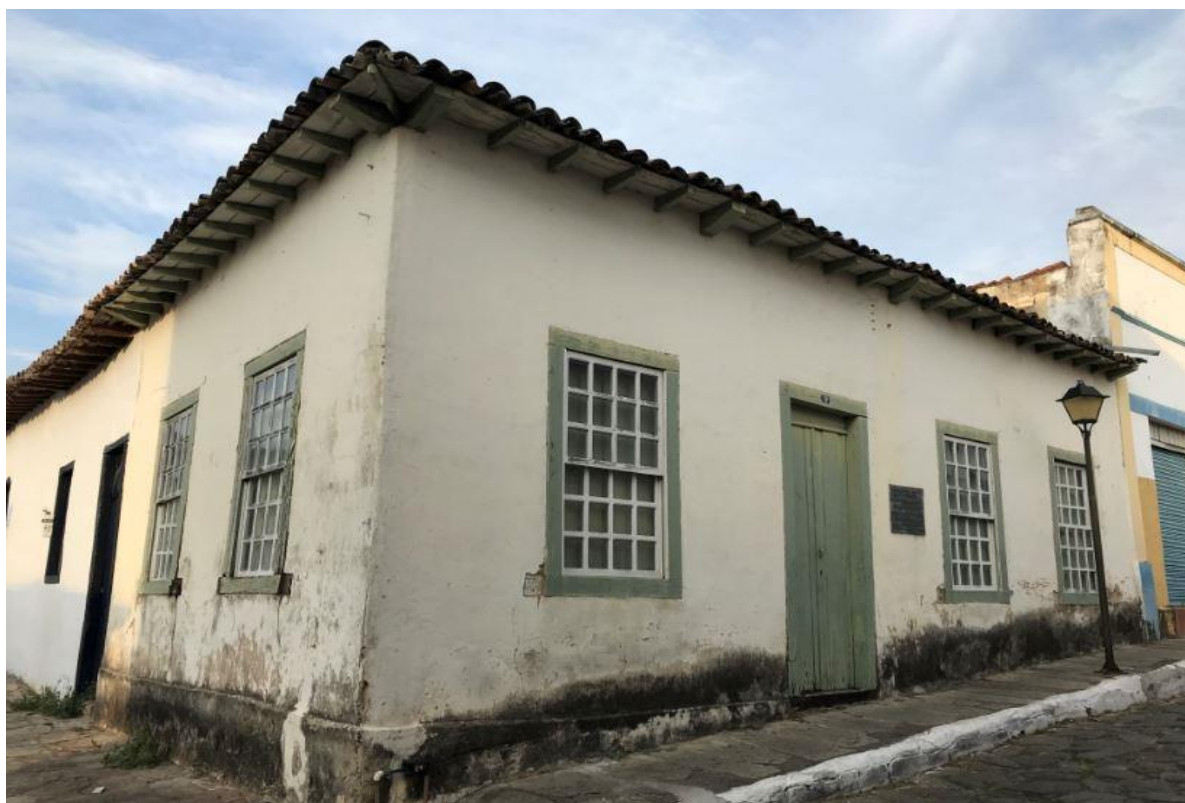
Figura 3 - Prédio do Gabinete Literário Goiano (2018)
