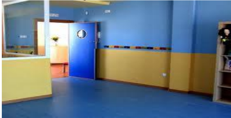
Figura 9 – Piso de Paviflex
