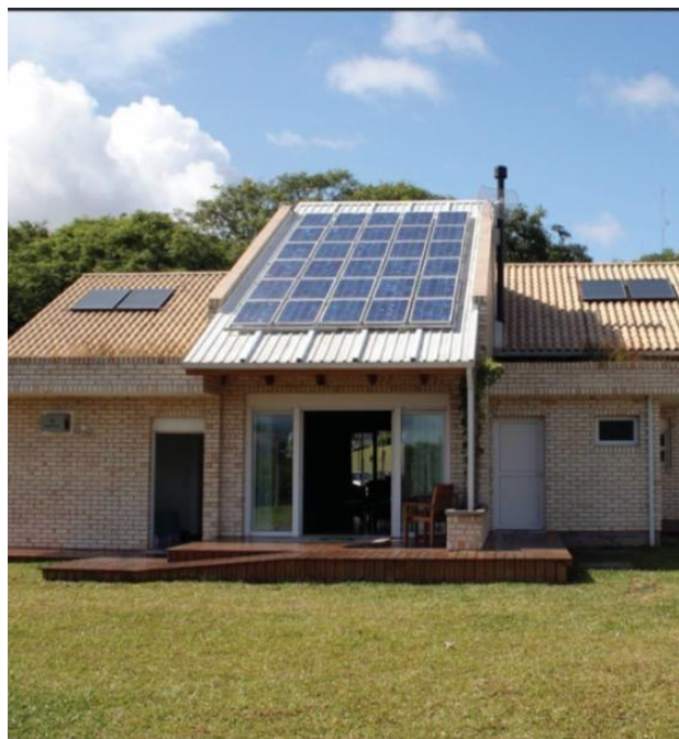
Figura 13 - Vista Nordeste da Casa.
