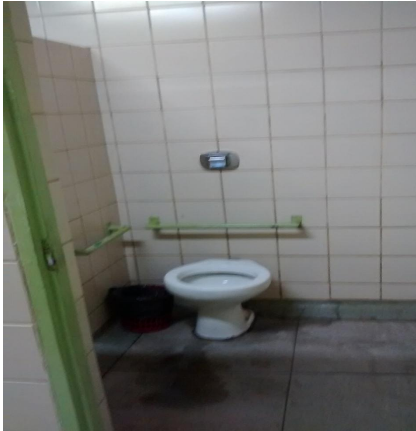
Imagem 9- Biblioteca B/ Sanitários
