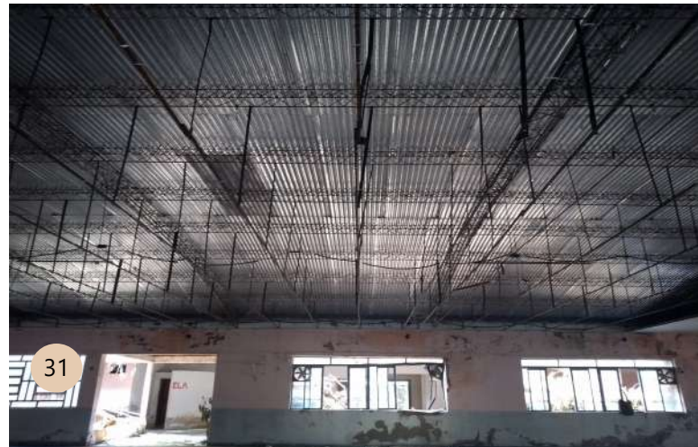
Figura 31. Vista Interna ao Edifício. Vista do telhado internamente. Fonte: LAGO, Juliana. Data: Março /2019
