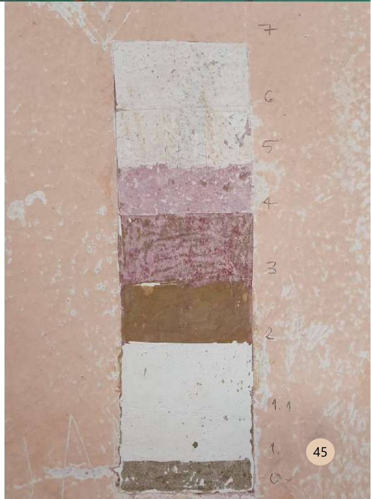
Figura 41. Imagem de pilar da fachada frontal do edifício Cantá Galo, nota-se a camada grossa de reboco aplicada a estrutura original do prédio, que foi construída de forma rústica. Fonte: OLIVEIRA, Karine. Data:31/10/2019.
