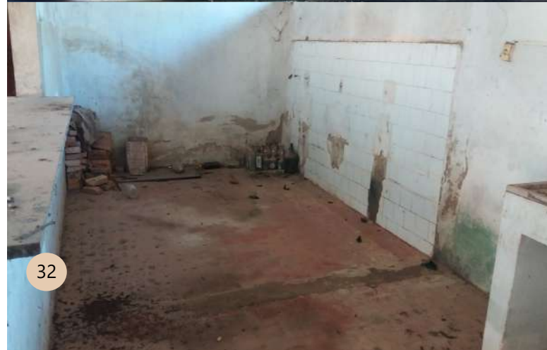
Figura 32. Vista interna ao Edifício. Ambiente Interno. Fonte: LAGO, Juliana. Data: Março /2019
