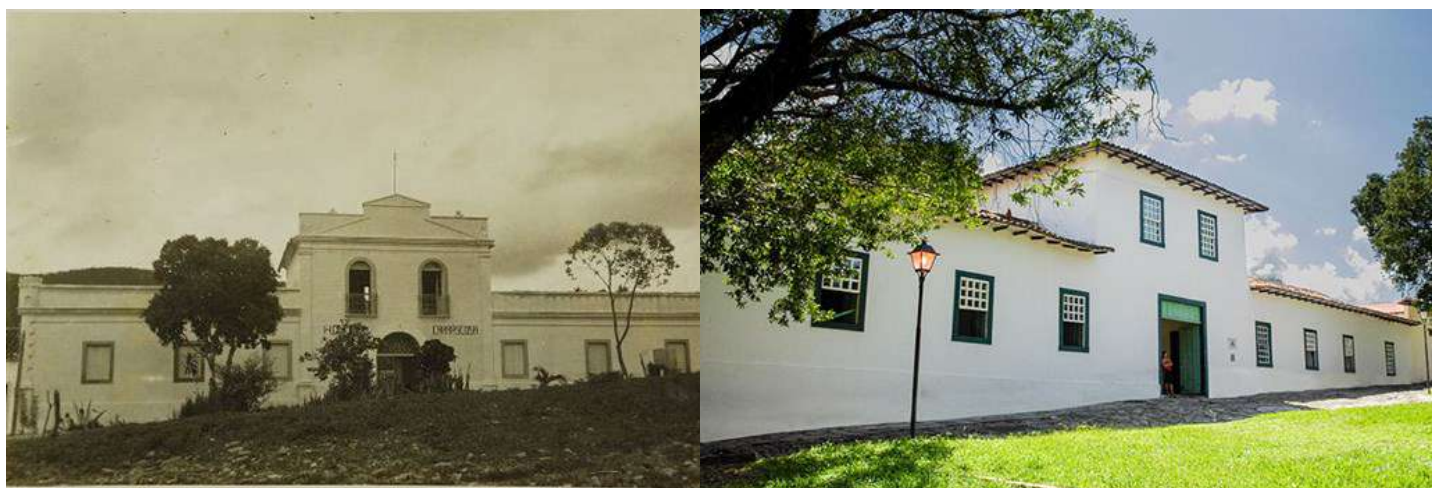
Figura 1. Exemplo de Intervenção como propósito de recuperar o aspecto original da edificação: restauração do Quartel do 20º Batalhão de Infantaria (Quartel do XX). A imagem mostra o aspecto da edificação antes da intervenção, percebe-se platibanda e verga em arco pleno nas aberturas da torre principal. Fonte: Acervo Digital do IPHAN. Data de Acesso:29/01/2019. Figura 2. Imóvel atualmente nota-se que houve a remodelação da fachada com aspectos coloniais. Acervo Digital do IPHAN. Data de Acesso: 29/01/2019
