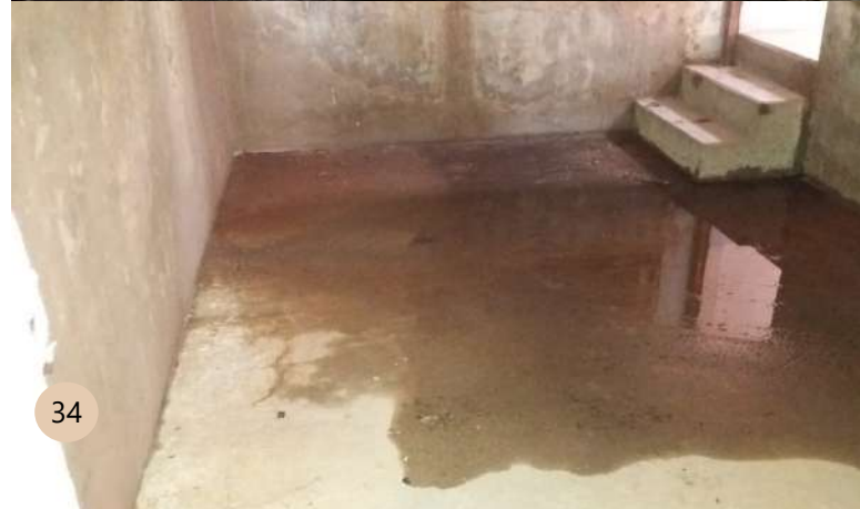
Figura 34. Vista Interna ao Edifício. Imagem de piso interno. Fonte: LAGO, Juliana. Data: Março /2019
