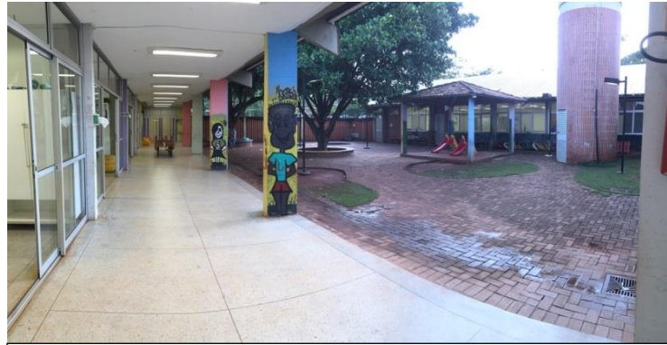
F02: Visão panorâmica do Pátio 1. Fonte: Grupo de trabalho - estágio 2015.
