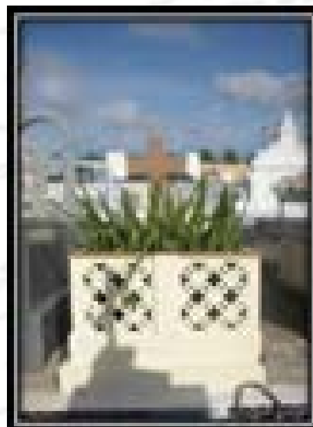
Figura 75 – Túmulo ladeado por paredes de cimento armado, com detalhes semelhantes a bordados de renda Cemitério Sant’Ana – Currais Novos
